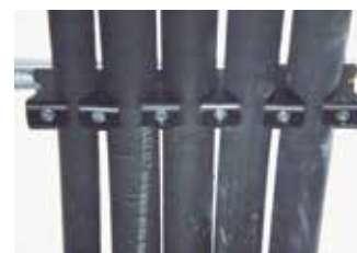
Zestawienie instalacji wykonanych za pomocą 5 przewodów rurowych z PVC o średnicy 40 mm.
