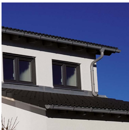
Połączenie dachu garażu ze ścianą
