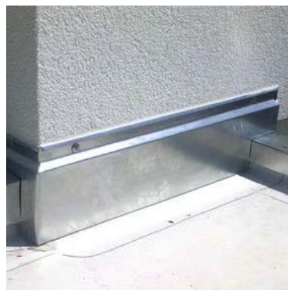
Montaż obróbki blacharskiej
