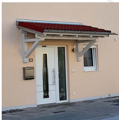
Połączenie okapu ze ścianą
